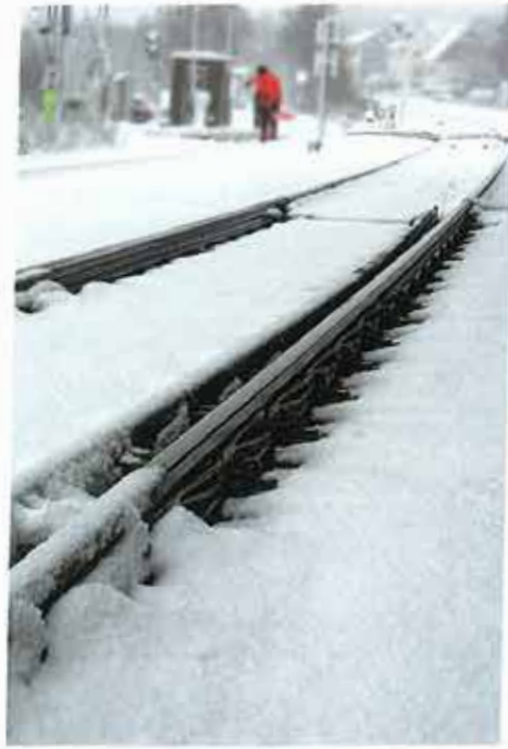
Bild 5: Eisfreie Weiche der Deutschen Bahn in Burbach, die zur Erprobung mit „EL-Point“ ausgerüstet ist
